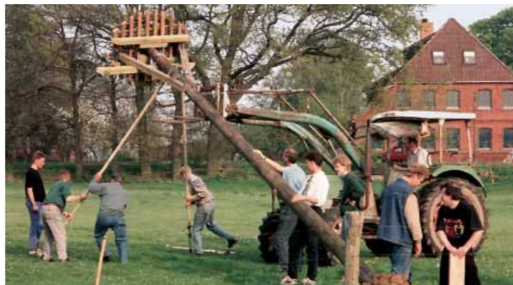
Errichtung einer Nistunterlage
